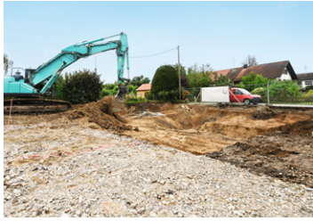
Vorbereitung des Baugrunds
