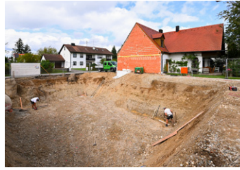
Aushebung der Baugrube
