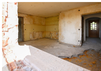
Entkernung Altbestand vor Abriss
