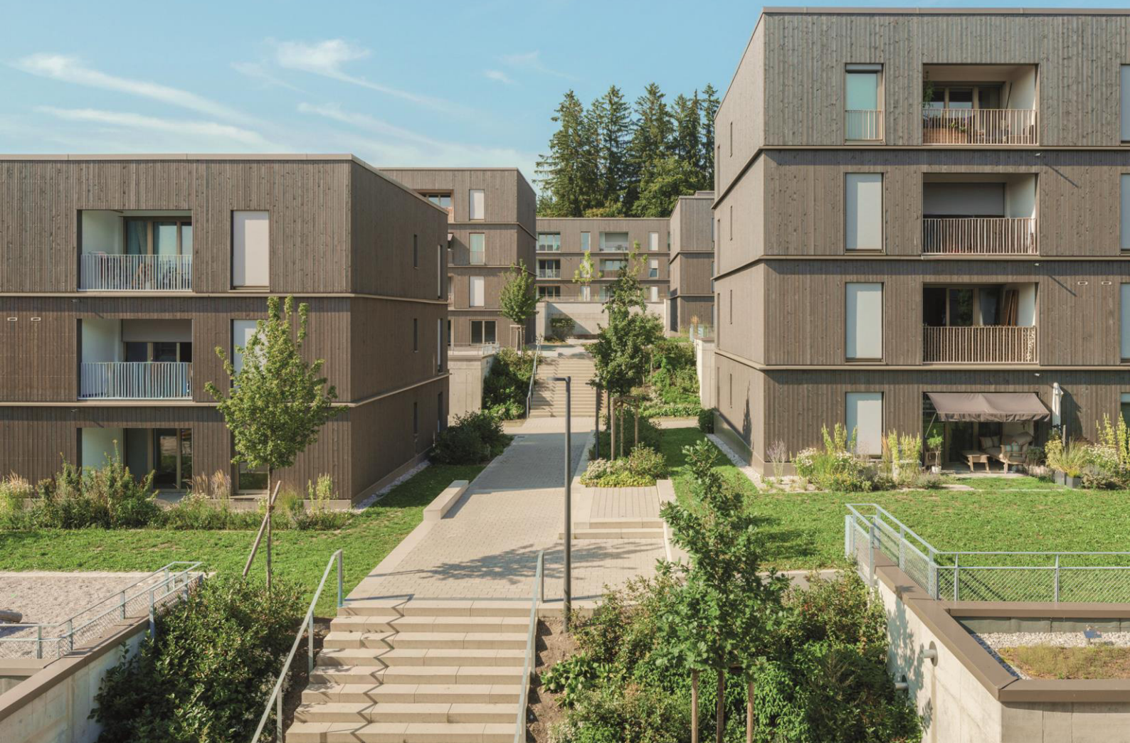
Wohnquartier in Penzberg Kommunales Wohnraumförderungsprogramm Bauherr: Stadt Penzberg Planer: H2M Architekten, München/Kulmbach Foto: Sebastian Schels
