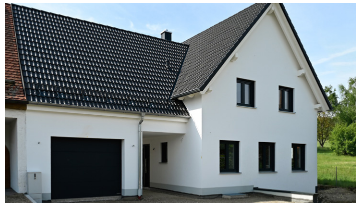
Fertigstellung des neuen Hauses
