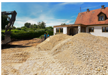
Gartenaufschüttung vor Abriss
