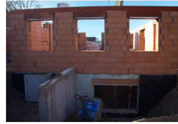
Rohbau mit Unterkellerung
